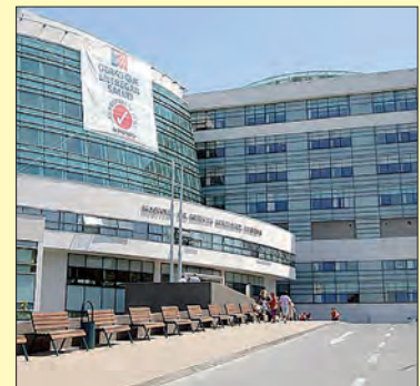
■ Hospital Regional de Temuco
