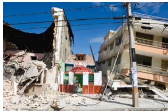
Daños en el distrito comercial, Puerto Príncipe.
