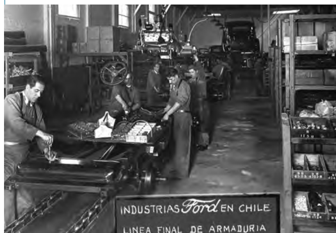
Línea final de armaduría, Industrias Ford en Chile (1935).
